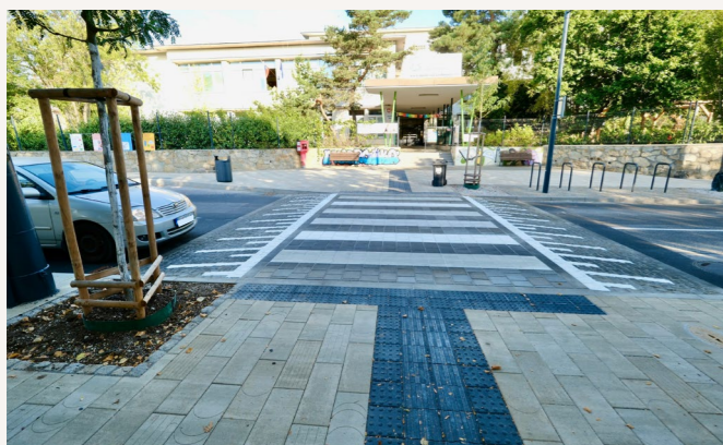
Vyvýšený priechod pre chodcov, ZŠ Mudroňova
